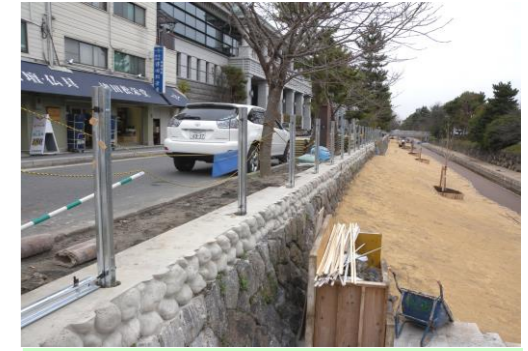
内蔵鋼材柱の立込み中
