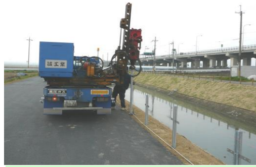
ガードレールの打込み機で内蔵鋼材建柱
