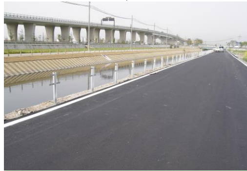
鋼材建柱とブラケットの取付完了
