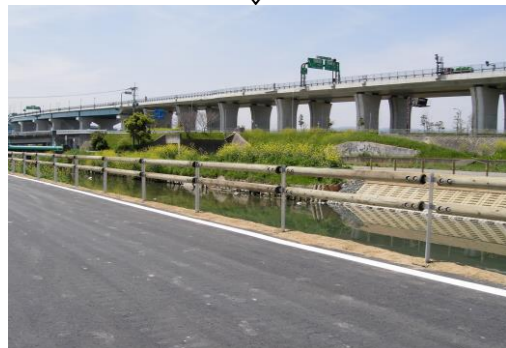
木製ビーム取付完了
