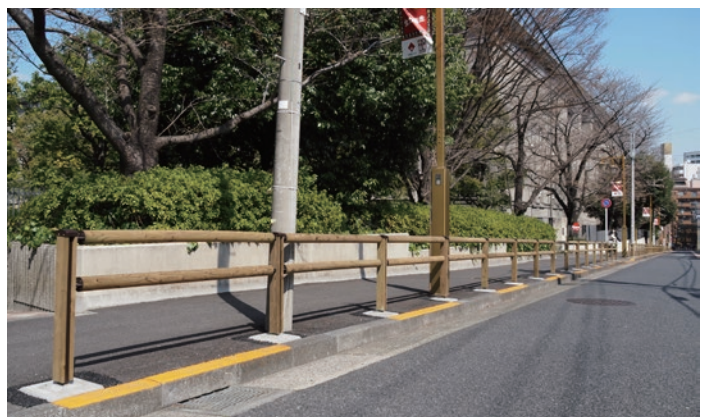
新宿区西早稲田の設置状況
