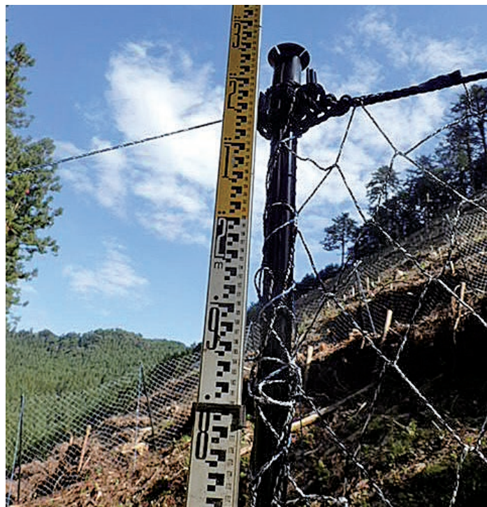
シカ柵設置状況
